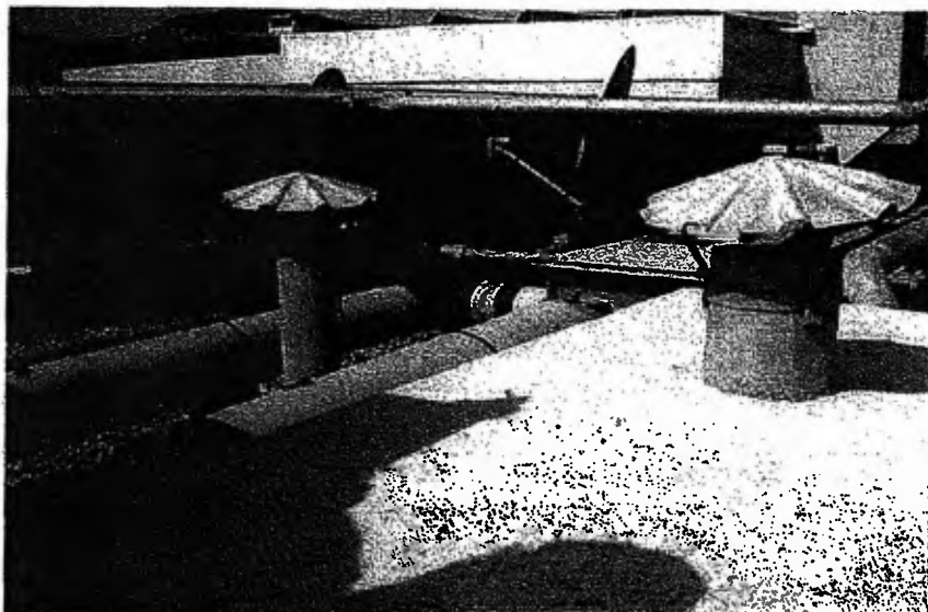
Photo 3 : Bâtiment B : sortie de ventilation gaine gaz à gauche et gaine VMC à droite vue de la terrasse
